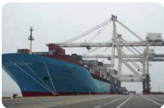
大型コンテナ船の荷役状況(アイランドシティ)
