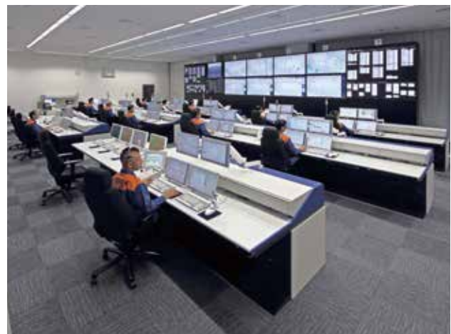
福岡都市圏消防共同指令センター
