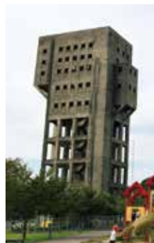
旧志免鋳業所竪坑櫓 (志免町)
